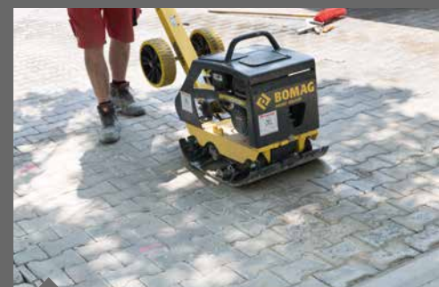
Abrütteln in ungebundener Bauweise
