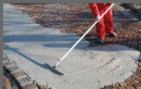
Verfugen in gebundener Bauweise
