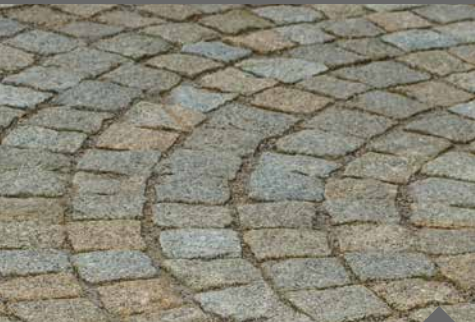
Verfugung in ungebundener Bauweise
