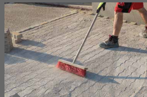
Verfugen in ungebundener Bauweise
