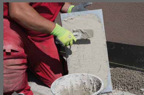
Verkleben in gebundener Bauweise
