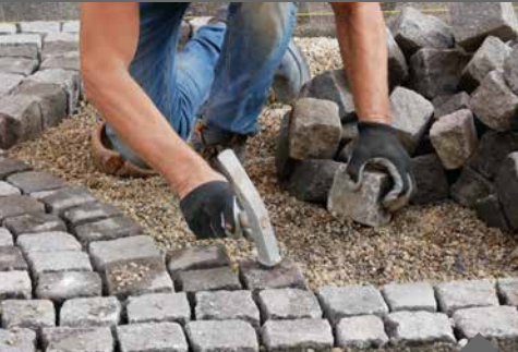
Pflastern in ungebundener Bauweise
