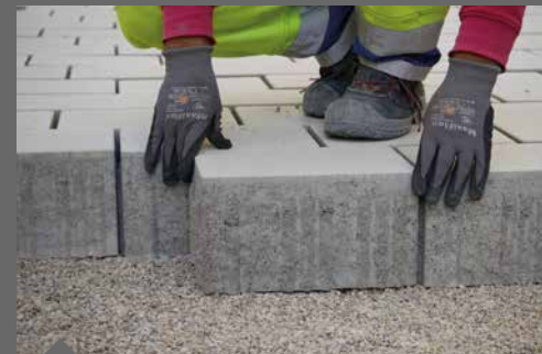
Verlegen in ungebundener Bauweise
