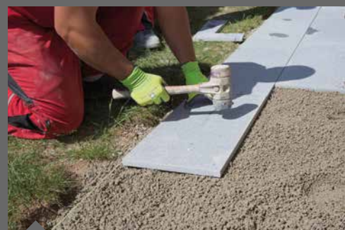
Pflastern in gebundener Bauweise
